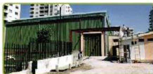
Pavilhão em construção
