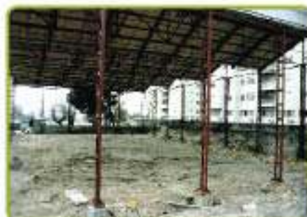
Construção do Pavilhão
